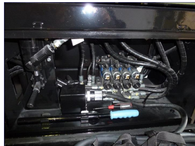
油圧機器の設置
