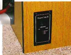
●LPアラーム。(ガス漏れ警報装置)
