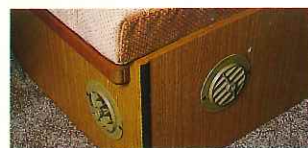
●クリーンヒーター吹き出し口。
